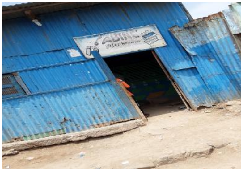
Photo 11 : la PAF0190 (cabine téléphonique) localisée dans emprises de la voie 7 (8m)
