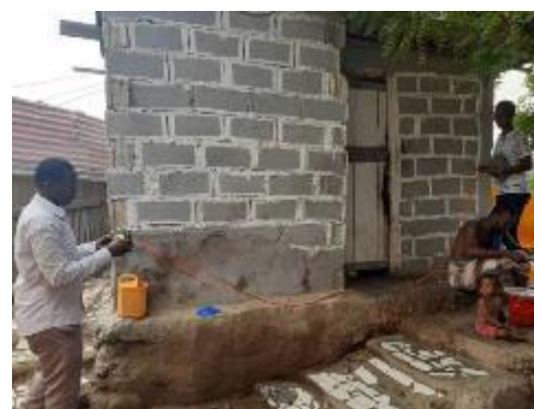
Photo 8 : évaluation des structures et équipements connexes
