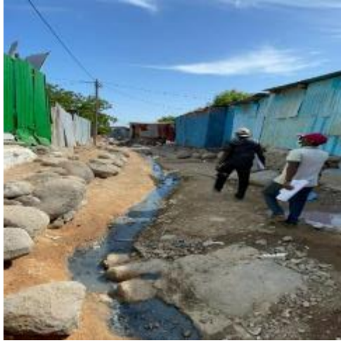
Photo 3 : Visite de reconnaissance des voiries dans le quartier de Balbala
